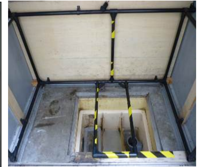
② 落下防止柵の製作
