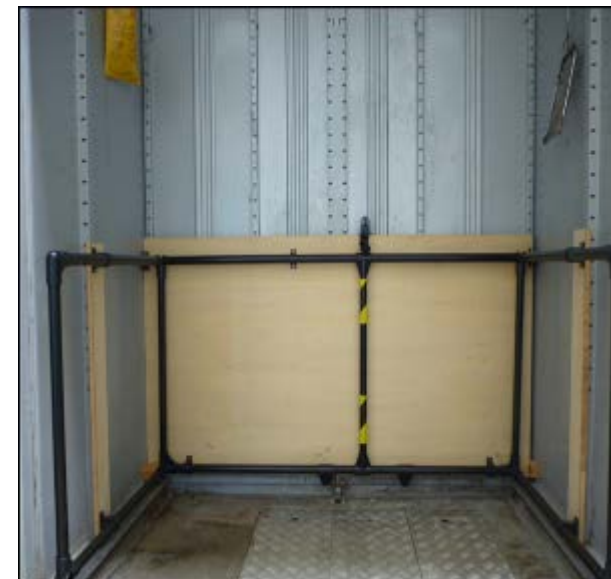
① 落下防止手すり
